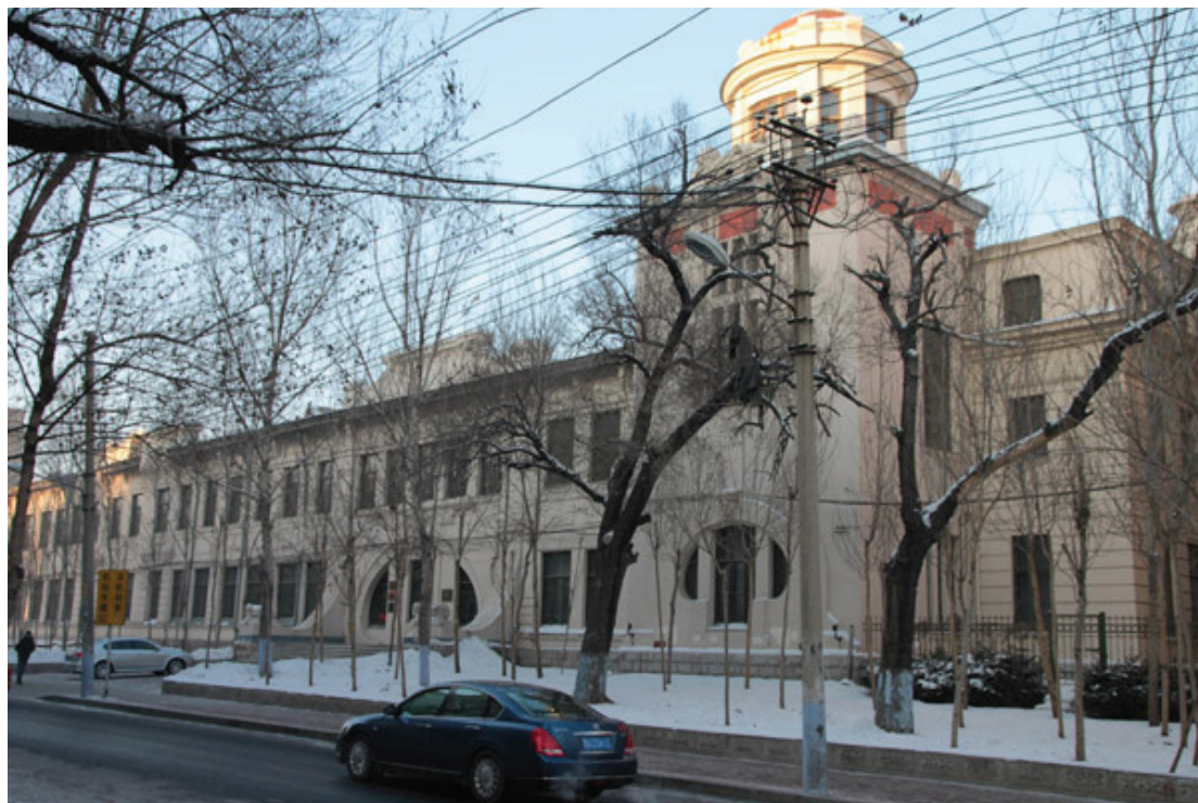
Рис. 4. Здание Харбинского политехнического института, 1906. Арх. П.С. Свиридов. Фото М.Е. Базилевича
