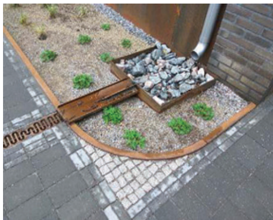
Рис. 8. Конструкция дренажного лотка, Северный Юргардштаден, Стокгольм. Фото В.В Дормидонтовой
