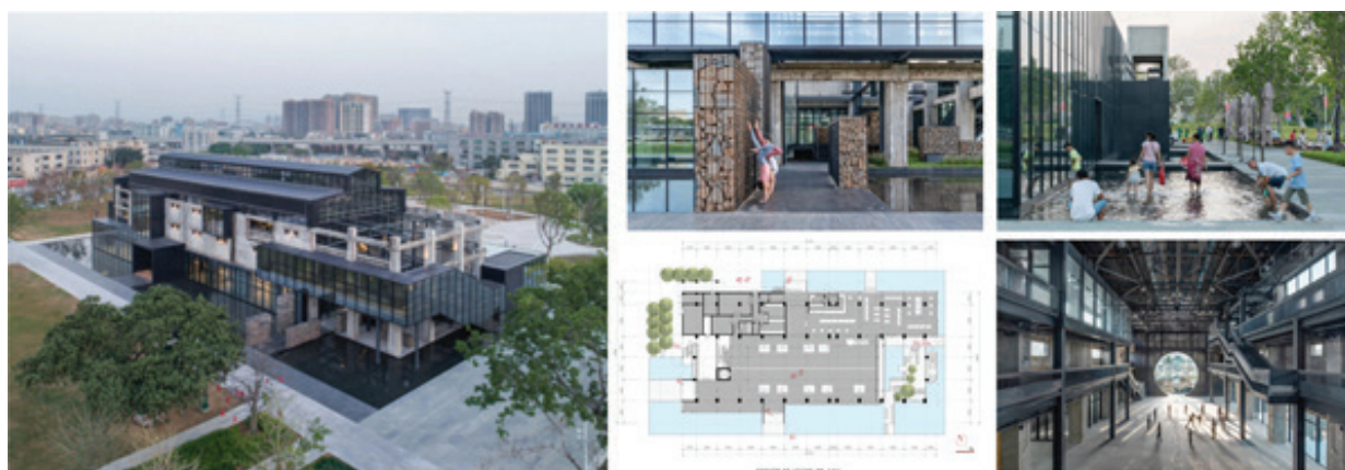
Рис. 6. Реновация дизельной электростанции в районе Шацзин, Шэньчжэнь, Китай. Арх.: ARCity Office, 2020.
