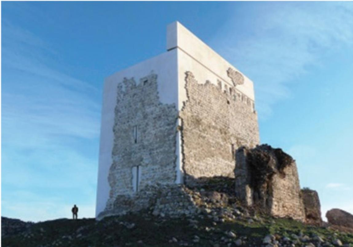
Рис. 4. Укрепление башни замка Матрера. Вильямартин, Испания. 2015.
