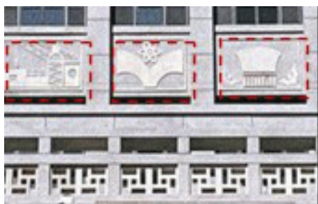
в) деталь оформления фасада корпуса Северо-Восточного университета. Облачные узоры и пятиконечные звезды
