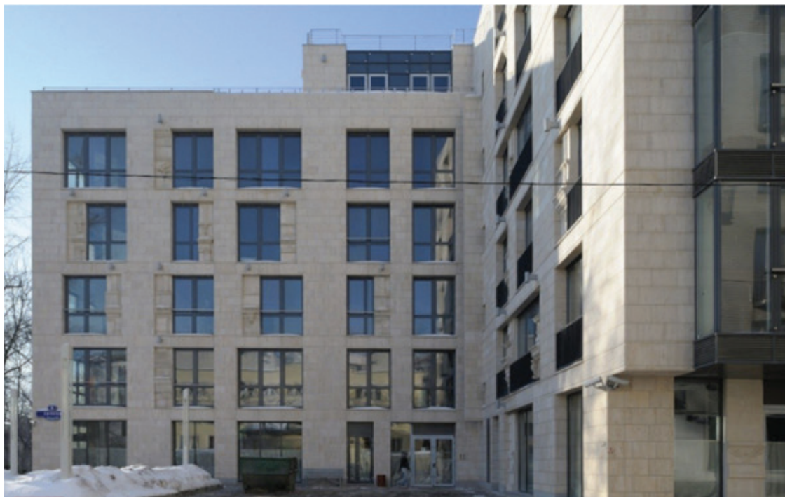
Рис. 1. Особняк в Хилковом переулке. Источник: https://archi.ru/projects/russia/3187/osobnyak-v-hilkovom-pereulke
