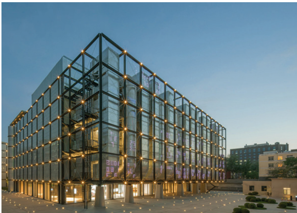
Рис. 5. Муниципальный дата-центр в Пекине от бюро «IILab», КНР, 2025. Фото: FernandoGuerra | FG+SG
