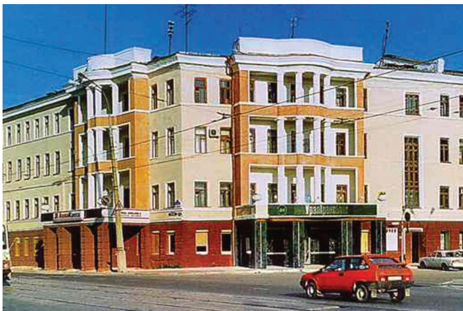
Рис. 6. Пр. Ленина, № 6 / ул. Огаркова, № 5. Гостиница «Северный Урал», 1935 г. Фото 2001 г. Источник: http://history.ntagil.ru/11_08.htm
